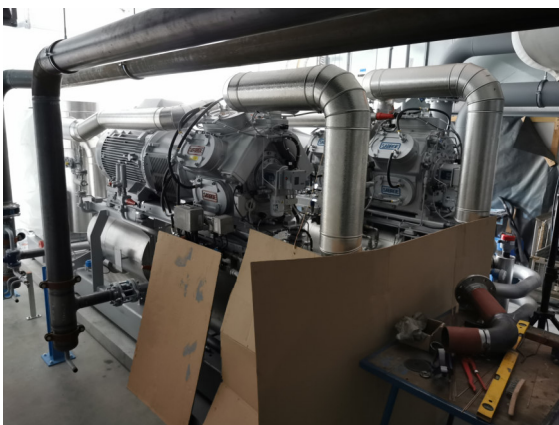
Abbildung 9: Großwärmepumpe des Herstellers JCI-Sabroe mit Rückkühlwerk der Fa. Thermokey während der Installation
