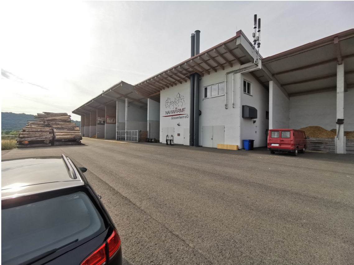
Abbildung 2: Heizzentrale der Nahwärme Gösenheim eG
