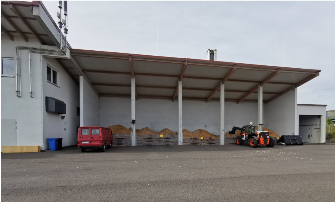
Abbildung 4: Raumaustragungen der Hackgutkessel mit Teleskopklader-Beschickung
