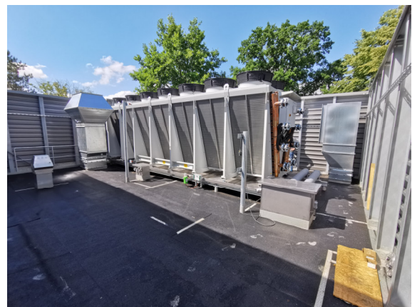
Abbildung 9: Großwärmepumpe des Herstellers JCI-Sabroe mit Rückkühlwerk der Fa. Thermokey während der Installation
