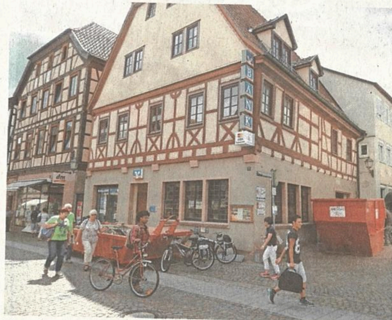
Die Raiffeisenbank baut die Lohrer Innenstadtiliale behindertengerecht um und schafft dafür in der Seitengasse einen barrierefreien Zugang. Foto: Thomas Josef Möhler
